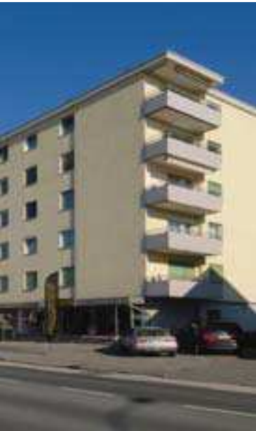
Das Mehrfamilienhaus im Vorarlberger Lustenau wurde 1966 mit einem Polystyrol-basierten WDVS versehen. In den vergangenen vier-einhalb Jahrzehnten war lediglich ein Renovationsanstrich nötig, um die uneingeschränkte Funktionsfähigkeit zu erhalten. © Günter Laznia, Bregenz, AT
