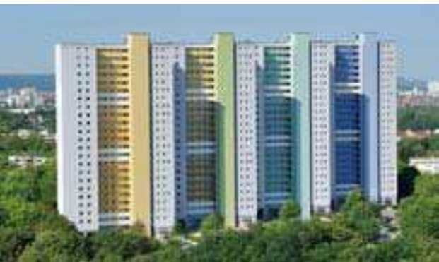
Die Wohnungswirtschaft ist eine treibende Kraft der Energiewende. Dank ihrer vielen energetisch sanierten Liegenschaften – wie hier beim Stuttgarter Julius-Brecht-Hochhaus – trägt sie bereits heute erheblich dazu bei, die Klimaziele Deutschlands zu erreichen.
